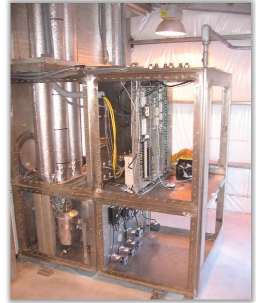
Kurionの小規模システム(大規模システムの部材は確保中)
