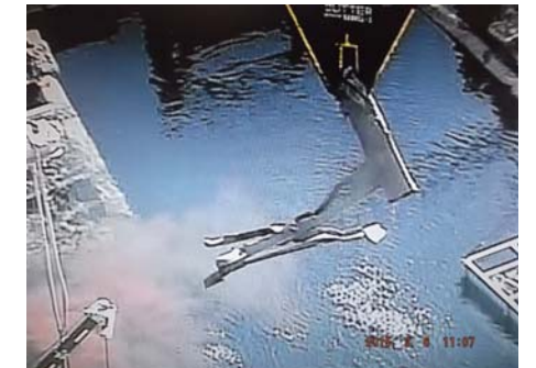
(3/6: 燃料交換機西側フレーム撤去作業状況)
