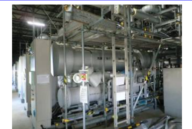
(陸側遮水壁 凍結プラント設置状況)
