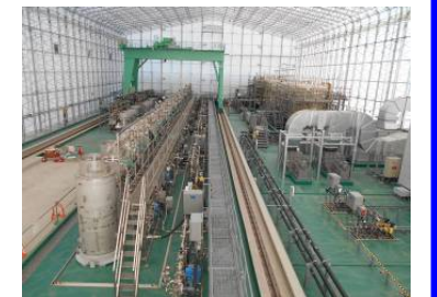
(高性能多核種除去設備の設置状況)
