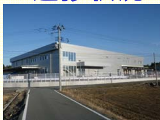
＜給食センター外観＞
