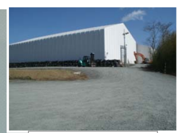
瓦礫保管テント
