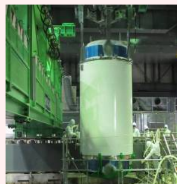
燃料取り出し状況
