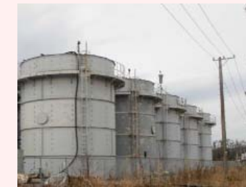
堰カバー設置前
