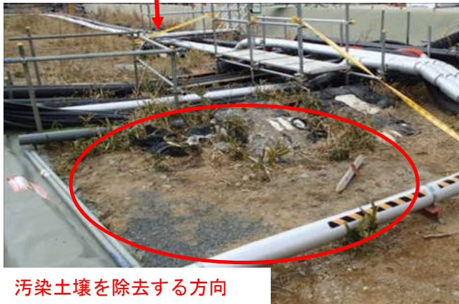
地表面付近の人力回収（すきとり） フェーシングを行い、カバーを設置
