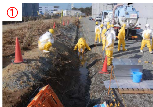
① 漏えい水回収後
