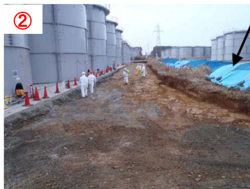
② 汚染土除去後
