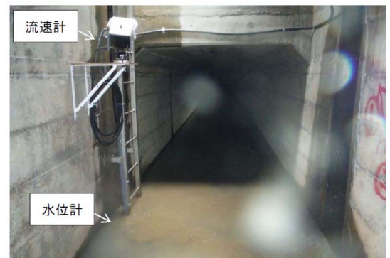
(上流から下流を見た写真)
