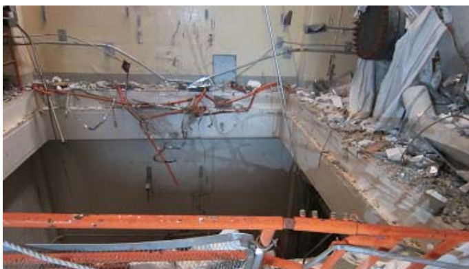
写真③：4階 西側外壁
