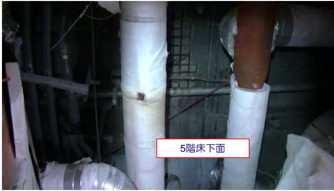
写真①：4階 天井(1)
