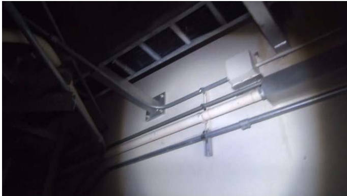
写真③：4階 シェル壁 (3)
