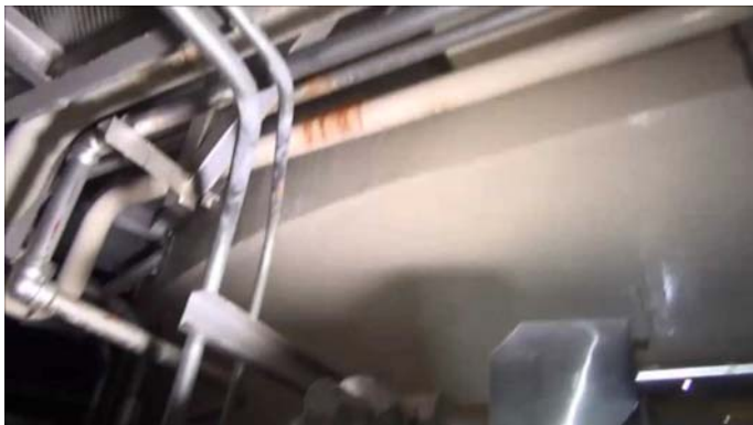
写真③：3階 シェル壁上部
