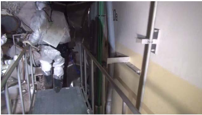
写真①：4階 使用済燃料プール壁
