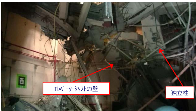
写真①：4階 北西側外壁
