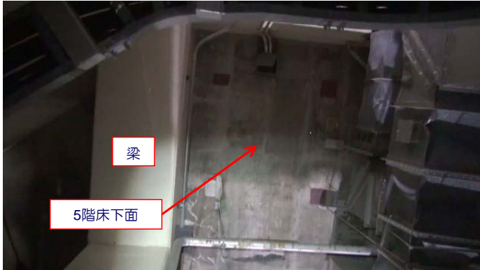
写真③：4階 天井(3)
