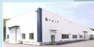
倒壊した工場・施設等の復旧支援
