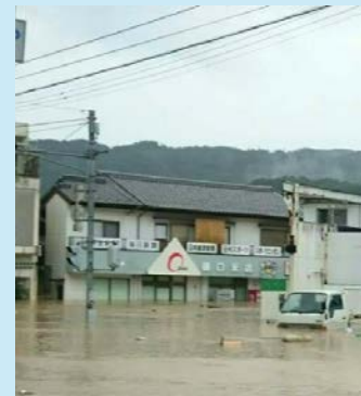
河川等の氾濫により 商店街に浸水
