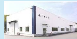
倒壊した工場・施設等の復旧支援
