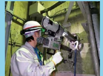
高経年化コンクリートの劣化調査
