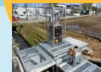
小水力発電施設
