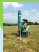
設備設置の ための調査
