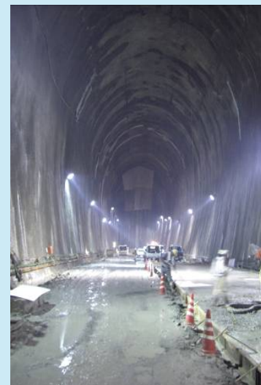
倉敷基地地下貯槽の様子 (建設時)
