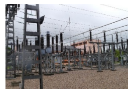
既存変電所調査
