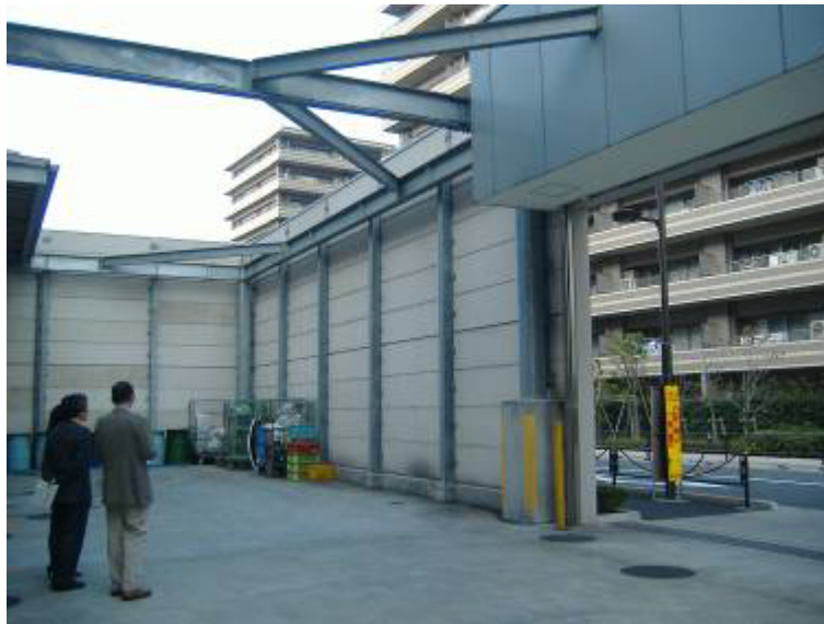
トラックヤード 防音壁、シャッター
