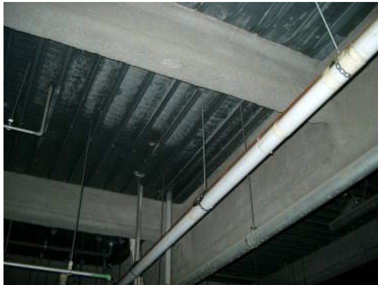
地下駐車場天井部分の騒音対策
