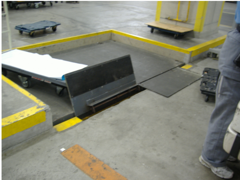
荷さばき施設 リフター緩衝材
