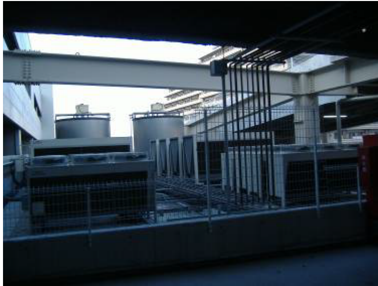
冷却塔・空調室外機置き場
