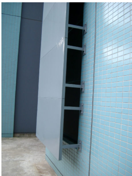
ガラリ外部に設けた遮音板
