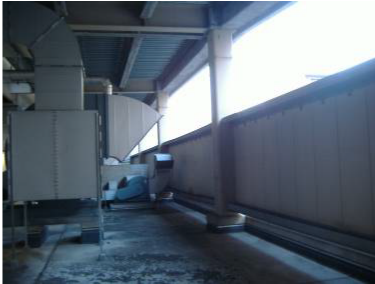
空調室外機置き場 防音・目隠し壁
