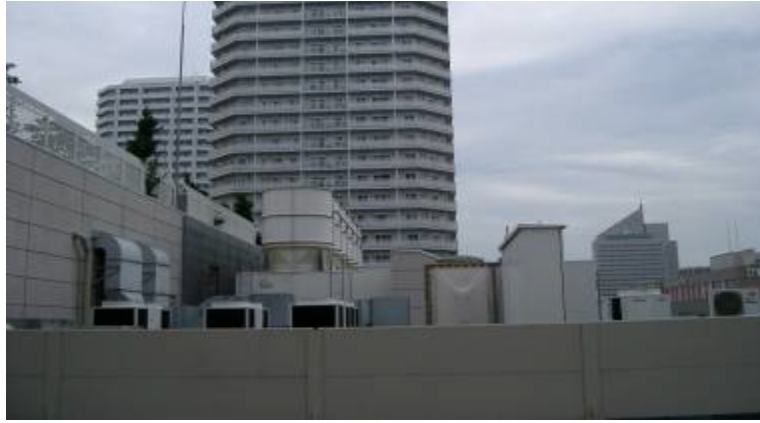
屋上における設備機器類の集中配置 騒音レベルの大きい機器を集合住宅から離して設置している。
