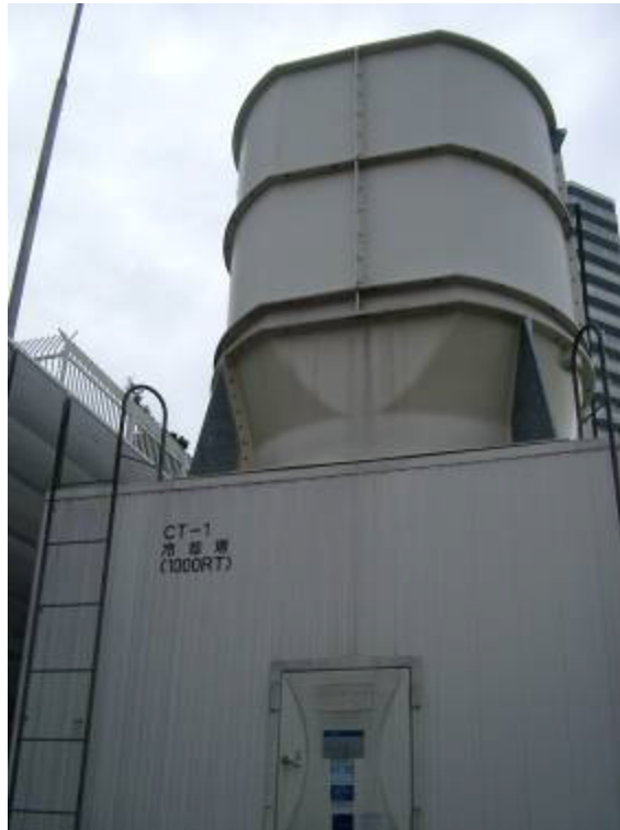
低騒音型冷却塔
