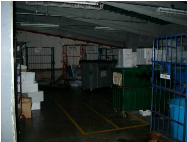
屋内に設置した廃棄物処理施設 廃棄物処理施設も屋内化することにより、騒音の伝搬を防止している。
