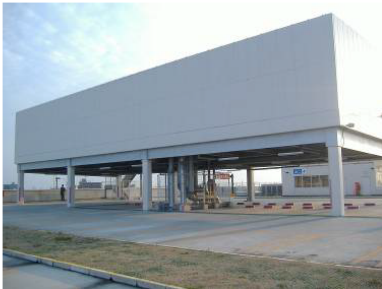
屋上氷蓄熱冷却塔 防音・目隠し壁
