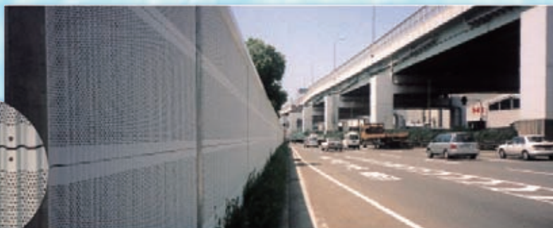
としぶ ひかりしょくばい こうつうりょう ああ どうろ しゃおんへき め 都市部では、光触媒を交通量の多い道路の遮音壁に塗ることで、 そうおん はいき がい ていげん せつび 騒音と排気ガスの害を低減する設備にできます。
