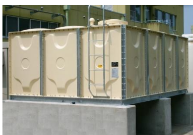
ボルト組立式パネル水槽
