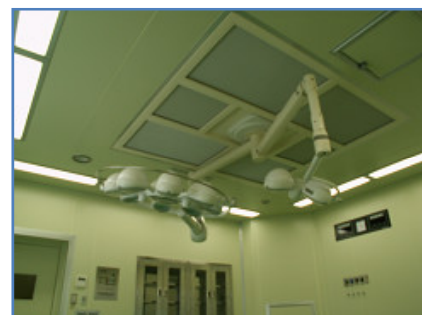
クリーン空調吹き出し口
