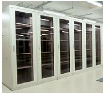
データセンター内部
