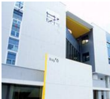
KRP データセンター(6 号館)
