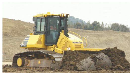
【写真】ICTブルドーザー D61PXi-23
