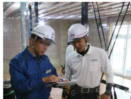
施工現場でのIT活用の様子
