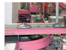
●各々のガラス粉碎機へ 分離したパネルガラスとファンネルガラスは各々の粉碎機に運ばれます。
