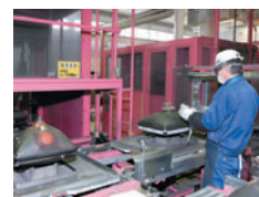
●ブラウン管の解体 前面のパネルガラスと背面のファンネルガラスの取り外しがポイントです。 補強バンドをはずして粘着テープや接着剤の残りやラベルなどを除去します。
