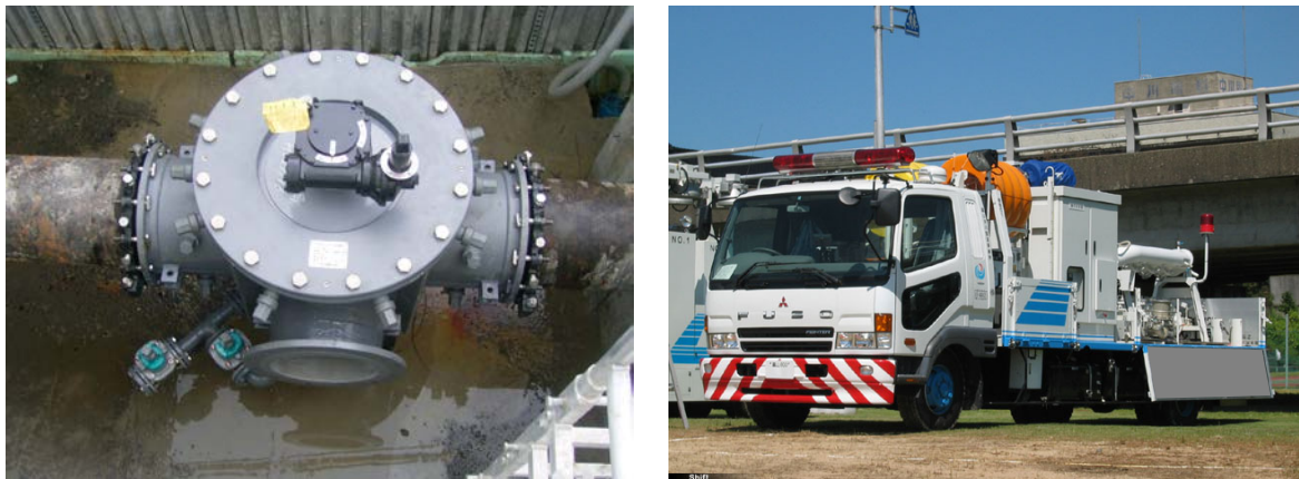
図 3.1 農業用水管からの取水イメージとポンプ車
