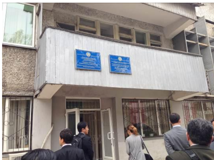
図表・12 アルマティ地域がんセンターの外観
