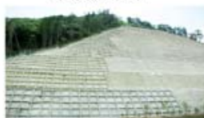
土木部(法面工事)
