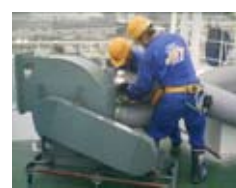
ダクト清掃機材取付中
