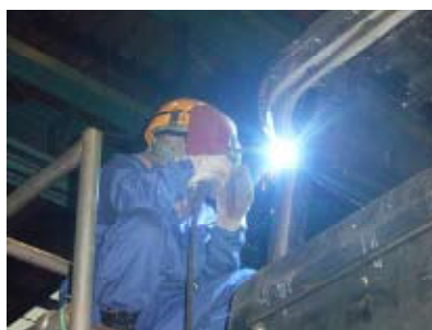
電気機関車構体の溶接作業
