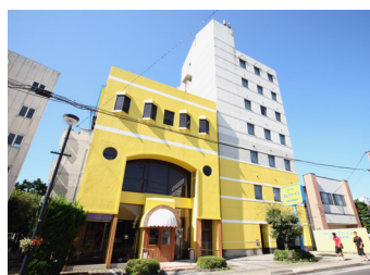
西那須野_外観
