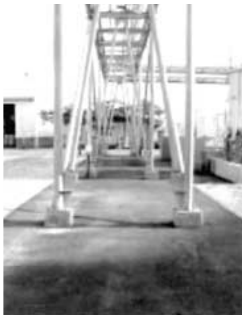
■ 図 2.1-2 配管ラック下の舗装化
