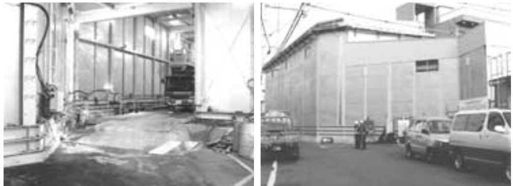
■ 図 2.2-1 大田区の汚染サイト（遮蔽された掘削除去現場の内側と外側）
