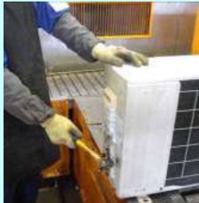
室外機カバーを外す
