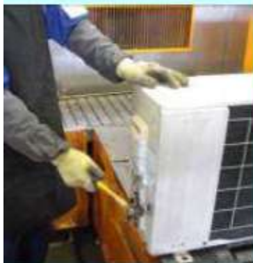
室外機カバーを外す
