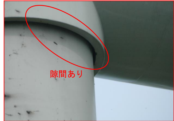
図 3-12 ナセル(発電機側隙間)
