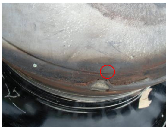
亀裂起点 A
