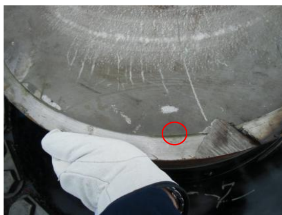
亀裂起点 B
