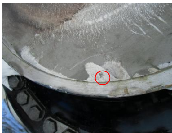
亀裂起点 C
