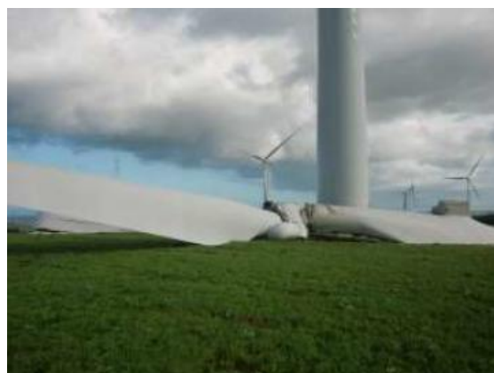
図1-5 ロータハブ落下状況
