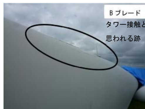
図 3-19 B ブレード タワー接触と 思われる跡
