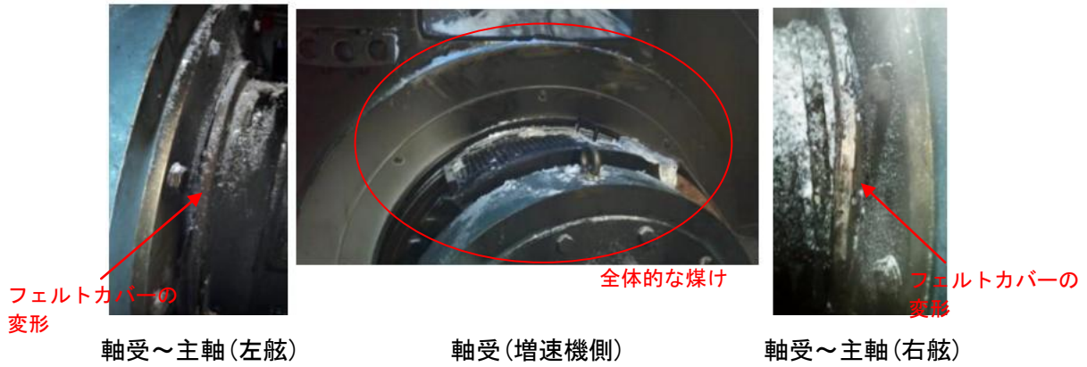
図 4-8 苫前 7 号機の軸受焼付き状況 (2011. 12. 26)
