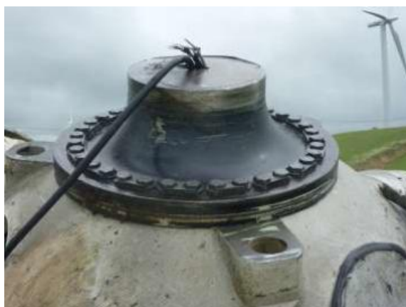
図1-6 ロータハブ落下状況(主軸破断状況)
