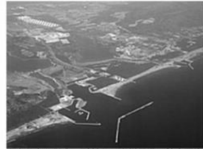
青森県上北郡六ヶ所村むつ小川原港 航空写真 (提供：国土交通省 東北地方整備局 港湾空港部)
