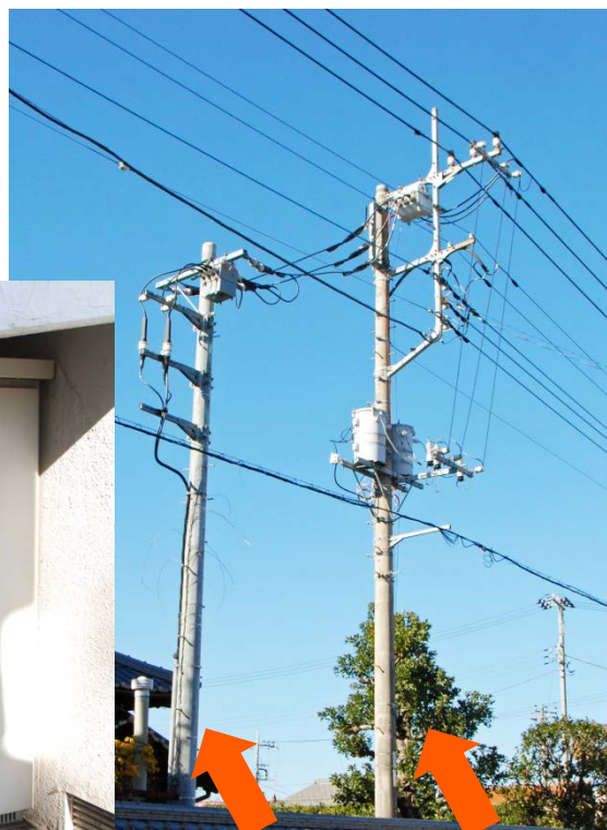
自家用架空引込柱 (6,600ボルト受電) 電力会社配電柱
