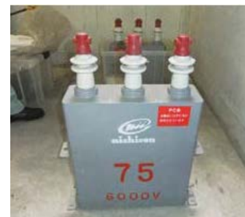
電力用コンデンサー
