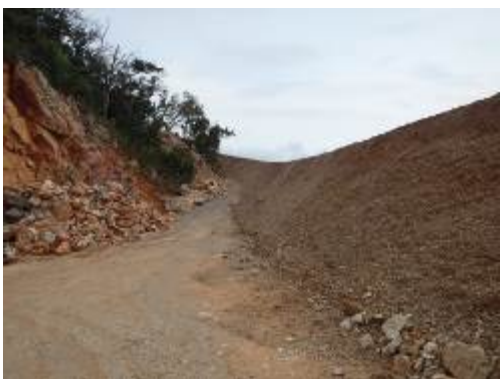
③中間地点斜面の土盛り
