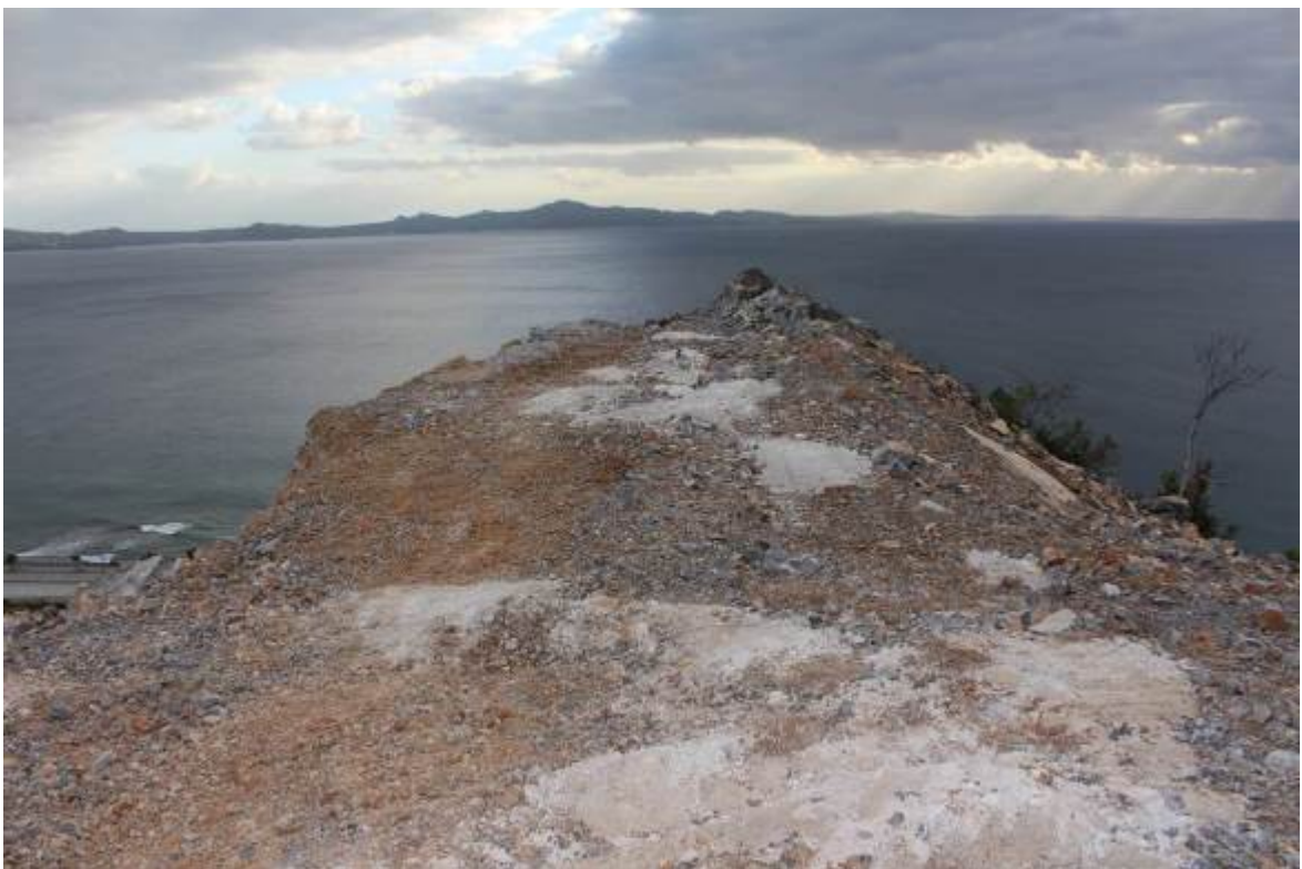
上部ベンチ 8.5 m L 頂部の状況 左側が発破面、先端部の下で崩壊発生
