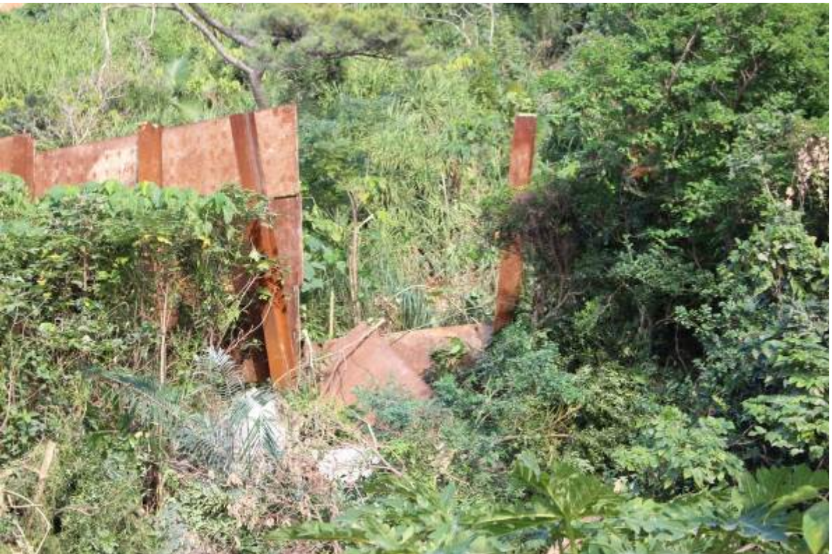
防護壁の破損状況（公民館側から撮影）
