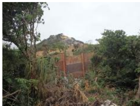
④鉄製防護壁の補強と内側土盛り
