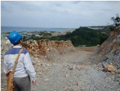
①既設落石受け深掘り溝
