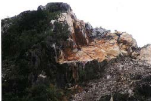
崩壊箇所（危険除去作業前）
