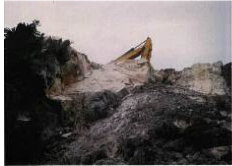
崩壊箇所（危険除去作業中）
