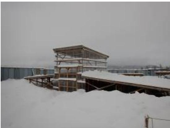
坑口装置に仮設の屋根を設置
