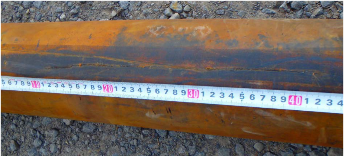
写真1: 導水管の亀裂の状況(底部より撮影)
