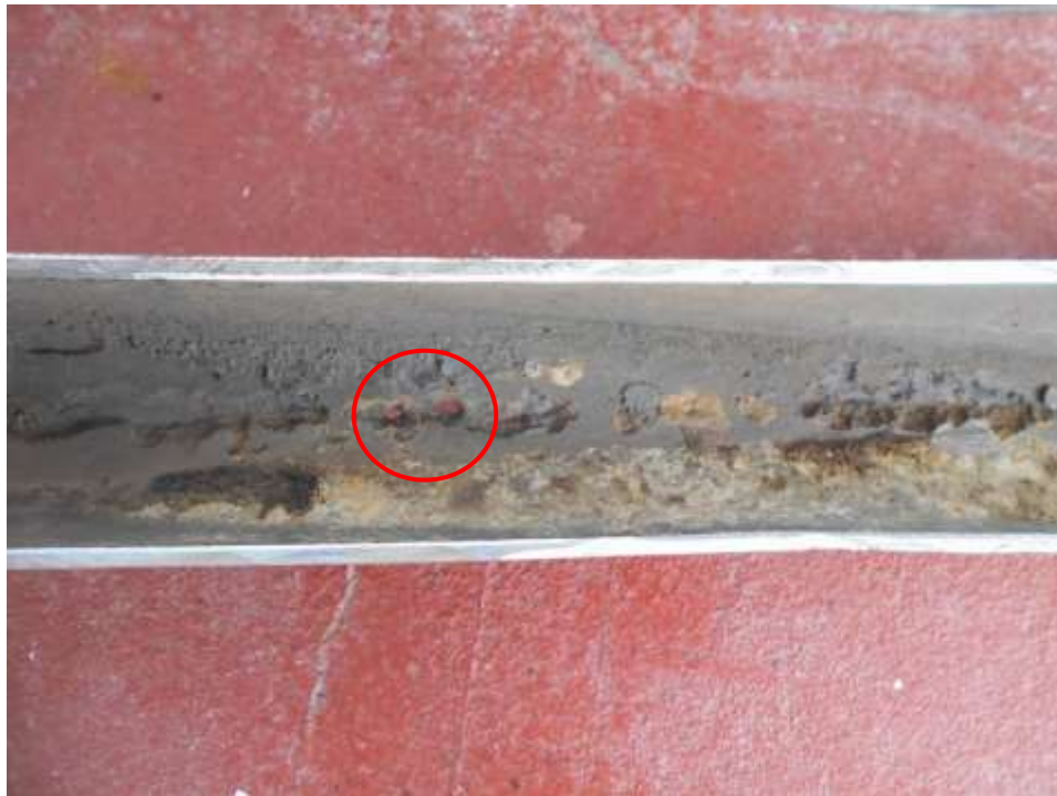
写真3：圧入管内面の穴あき状況（拡大）
