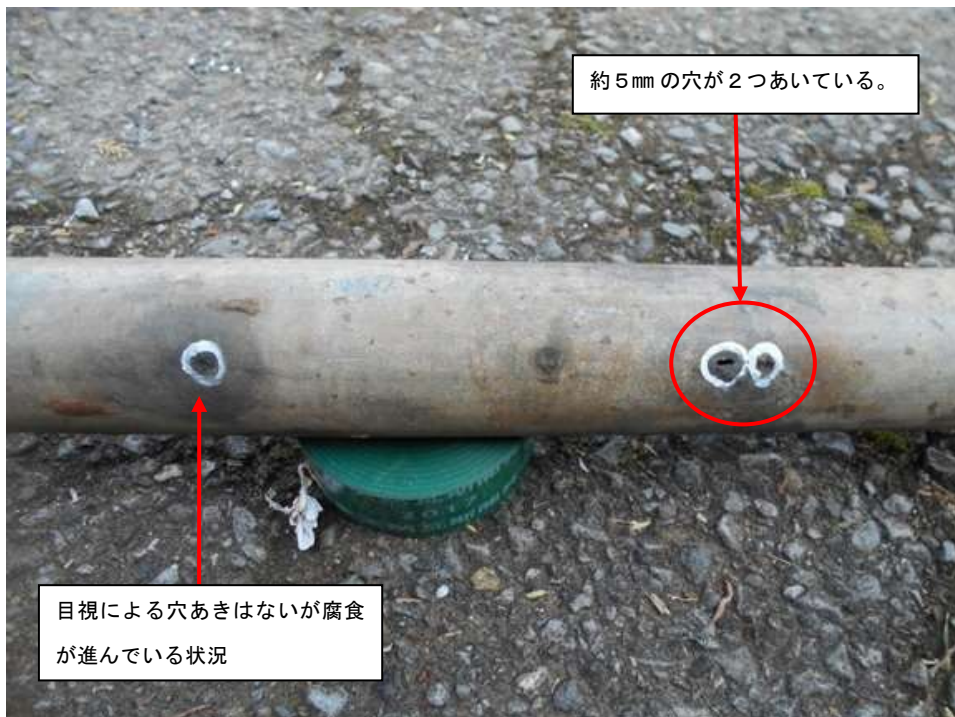
写真4：圧入管の外観状況
