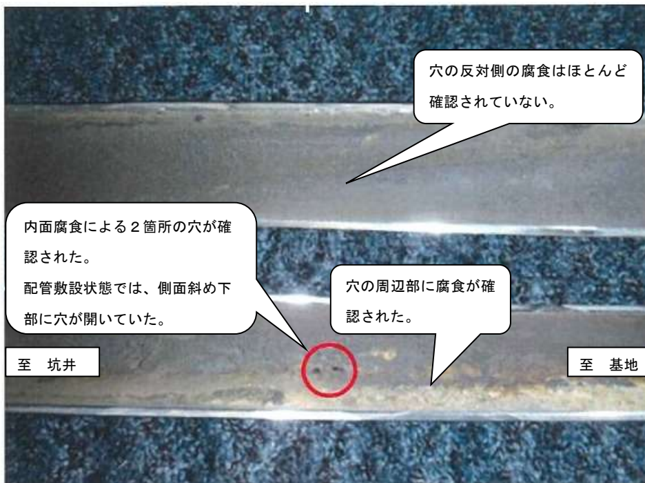
写真 2 : 写真 1 の圧入管を赤点線に沿って半分にカットした内面の状況
