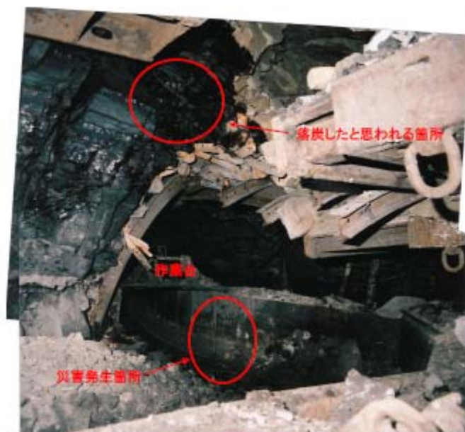
写真2 災害発生箇所（自走枠（切羽内）側から撮影）
