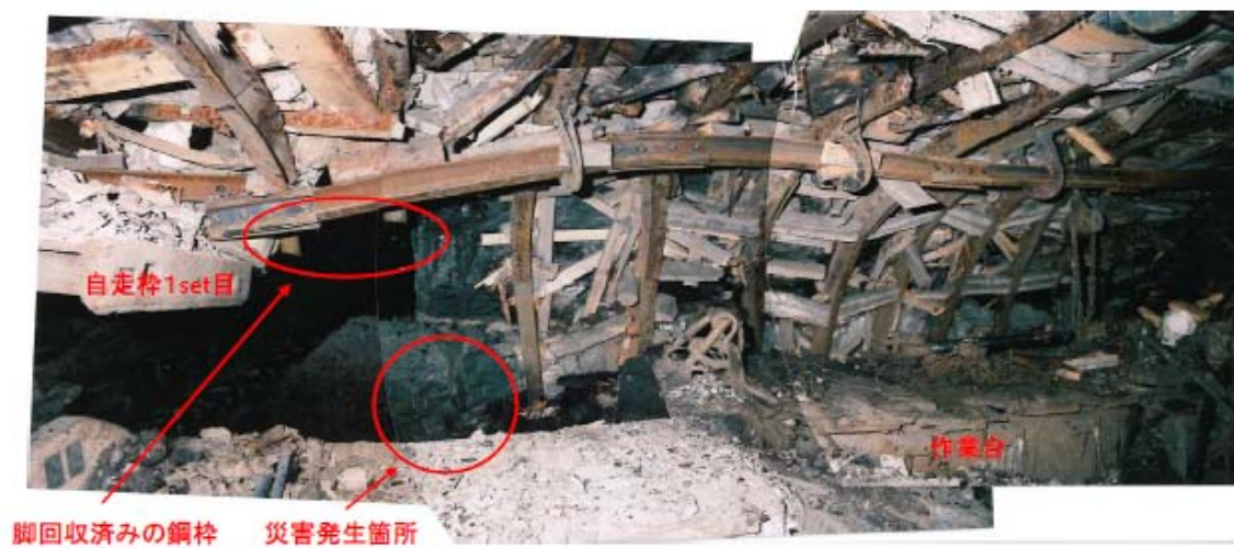
写真1 災害発生箇所（ゲート坑道側から撮影）
