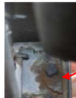
【フック裏側の溶接部が腐食しガタツキがあった状態であった】
