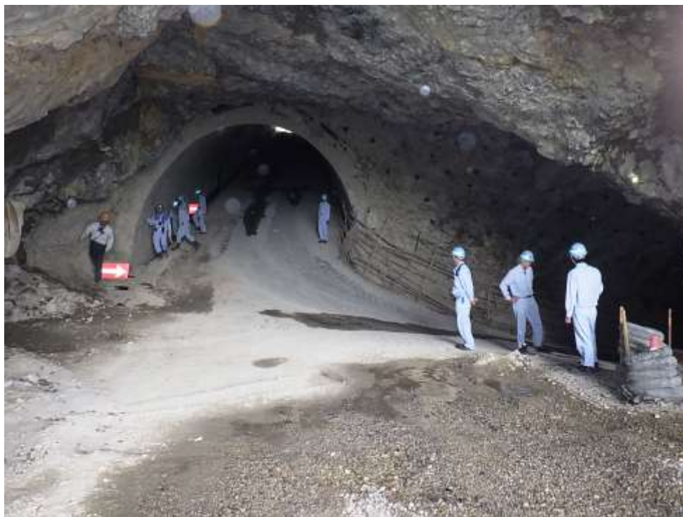
① 重機が横すべりしたずい道内L字角箇所
