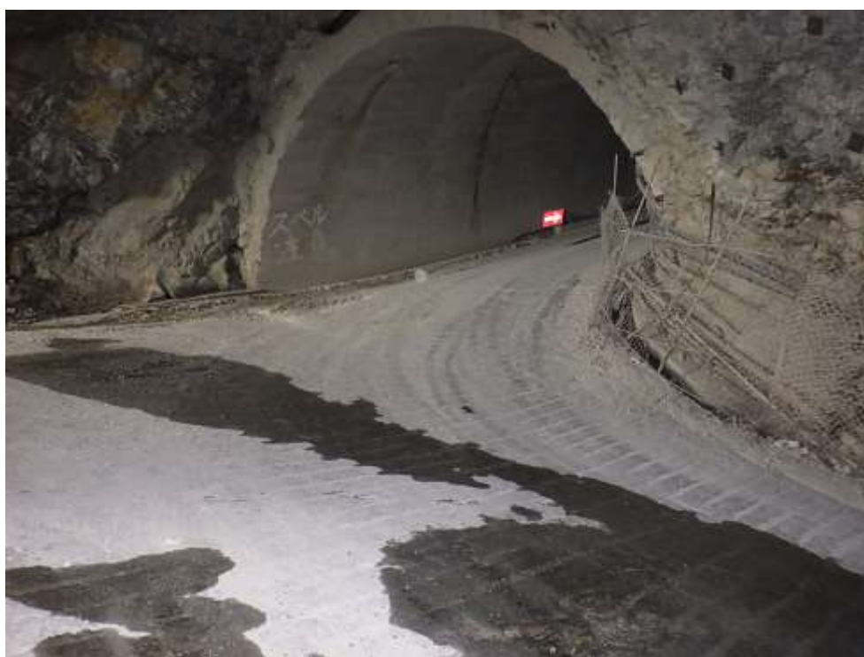
② 同コンクリート路面の状況
