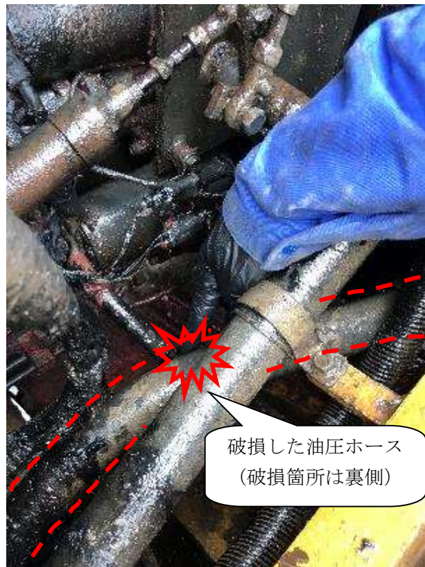
図 4. 破損した油圧ホース（拡大）
