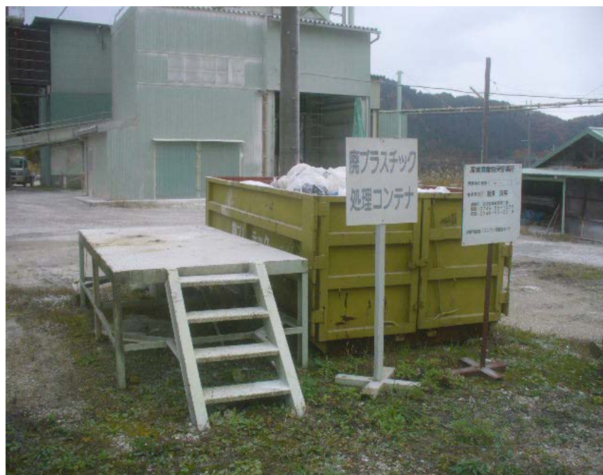
プラットフォームを設置
