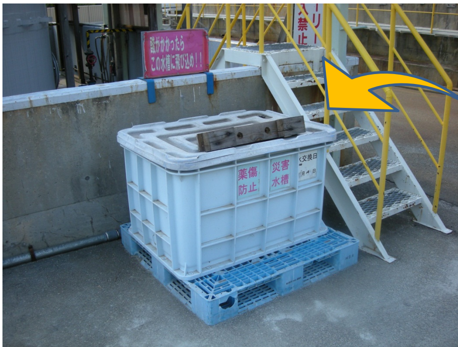
薬傷災害防止用の水槽
