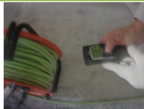
コードリールの表面温度を測定
