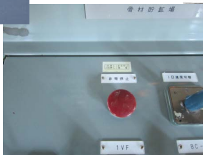
操作盤非常停止スイッチ
