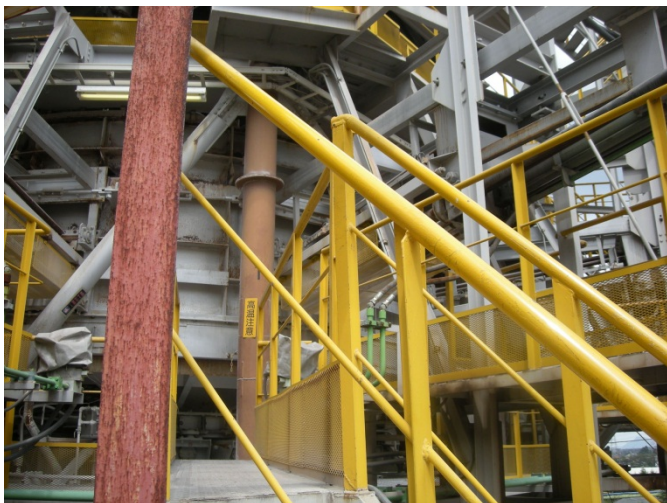
焼成炉周りの通路
