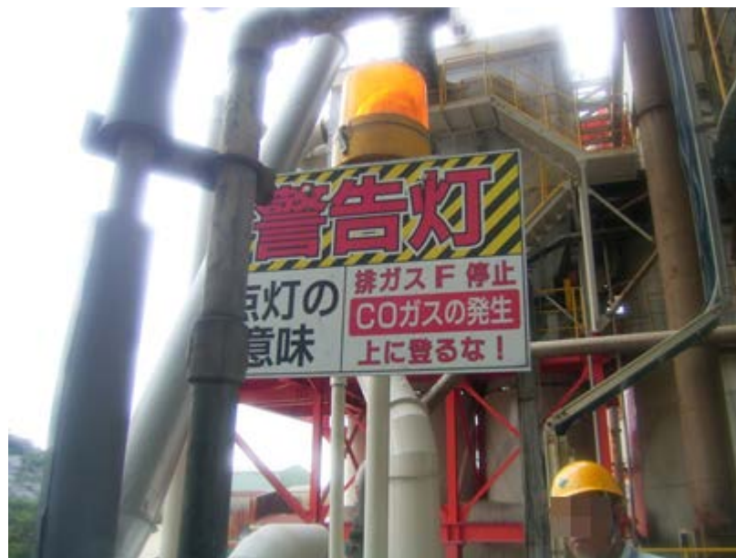
COガス警告灯
