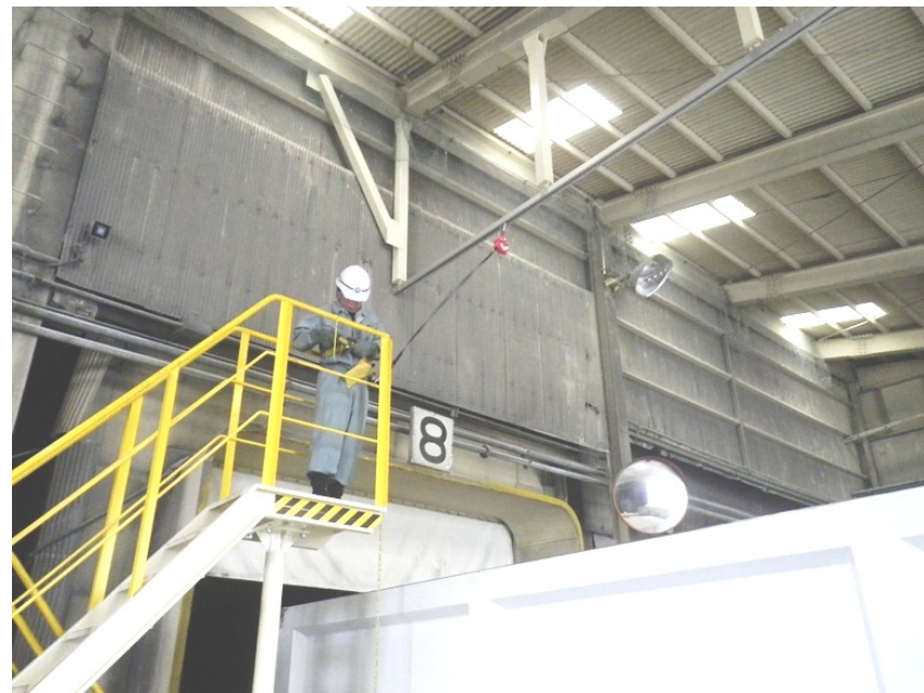
安全帯をレールに取付け転落防止
