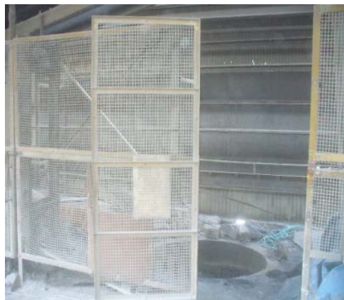
設備の周囲に柵を設置
