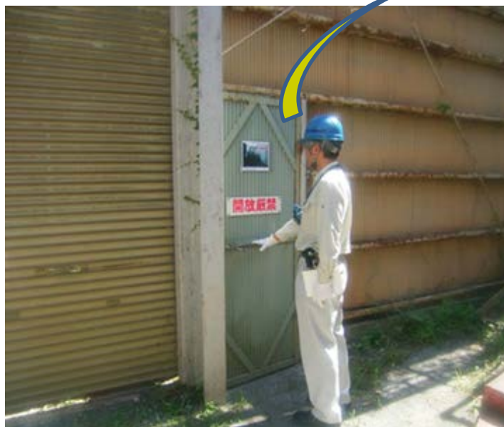
出入口の扉(外開きを内開きに改修)
