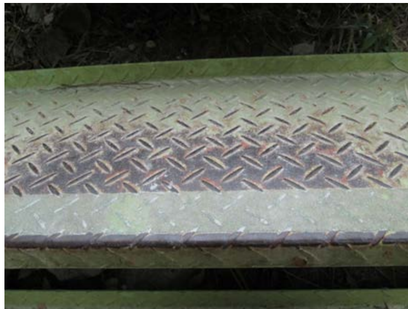
階段の滑り止めテープ(拡大写真)
