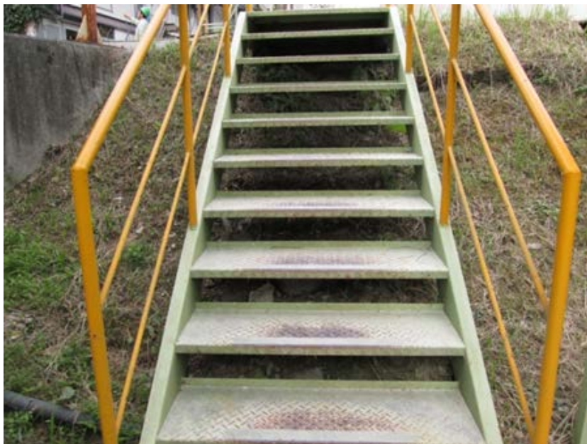
各ステップに滑り止めテープを貼り付け
