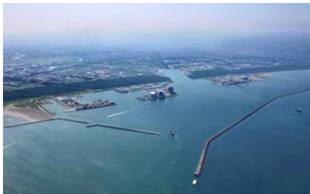
石狩湾新港（出典：石狩湾新港管理組合）
