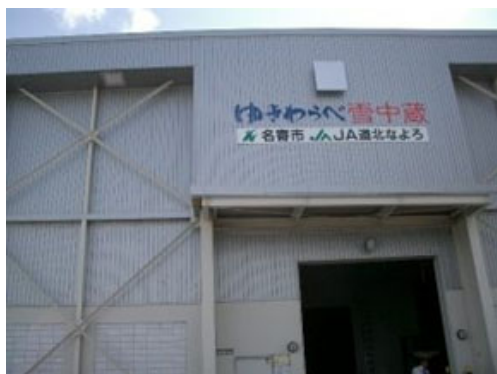
【雪室型もち米低温貯蔵施設】
