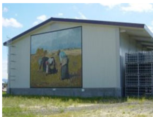
【農産物出荷調整利雪施設】
