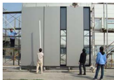
アルミカーテンウォールの製品検査風景
