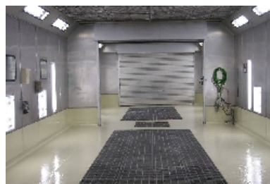
図2 VOC規制対応型塗装ブース
