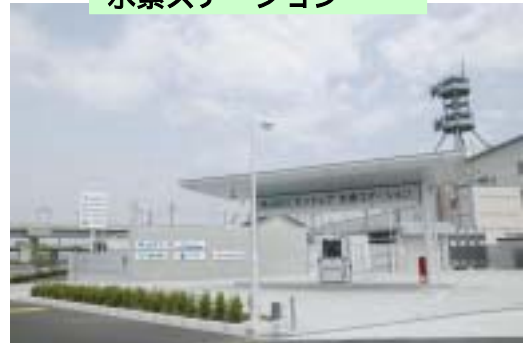
水素ステーション
