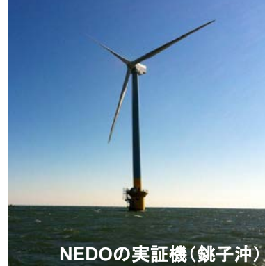
【洋上風力発電設備のイメージ】
