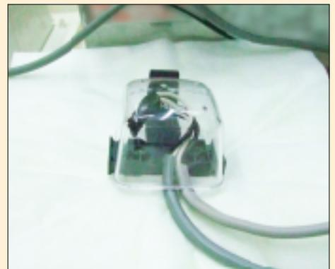
結線部に被せる埃よけジョイントボックスと不燃シート敷設による予防措置例
