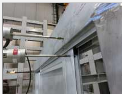
サッシの変形を確認
