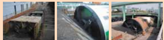
到達状況 (実証実験工事) 発進状況 (高速道路工事) 到達状況 (高速道路工事)
