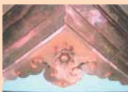
銅板張り唐破風 (金沢城河北門)
