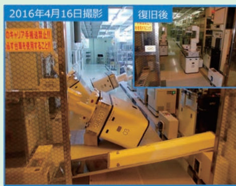
図2 熊本地震 川尻工場 クリーンルームの損傷は無く被害はほぼ想定内
